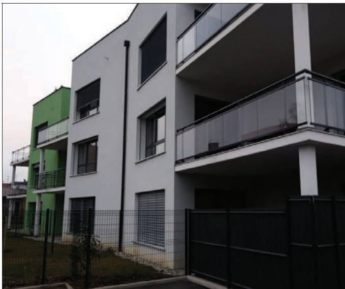
Construite dans le respect de l'éco-conception, la résidence Saint-Charles, à Kingersheim, est exemplaire aussi bien du point de vue de sa conception énergétique (cogénération, énergie solaire et bâti performant) que de son intégration urbanistique. C'est ce qui lui a valu d'être primée par GrDF.
