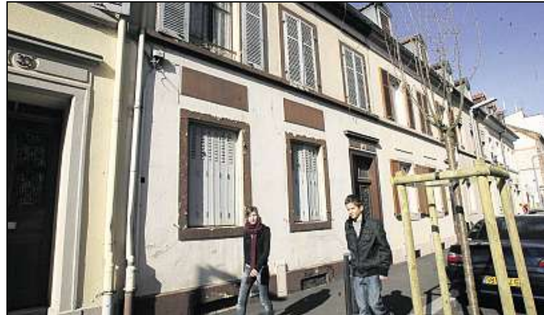
La rénovation de cet immeuble ancien, au 35, rue du Gaz à Mulhouse, sera l'un des chantiers pilotes du pôle. Démarrage des travaux à l'automne 2009. Photo Jean-Paul Domb
