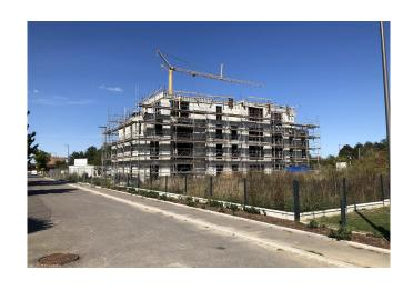
Le gros-œuvre sera achevé en ce mois d'octobre pour permettre la mise en place des fenêtres, de l'isolation extérieure et des étanchéités.
